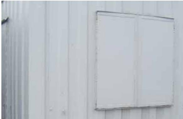
Abb.17 Anti- Vandal Container mit Fensterladen
