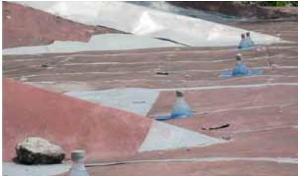
Abb.21 Ins Dach eingelassene Solarbulbs
