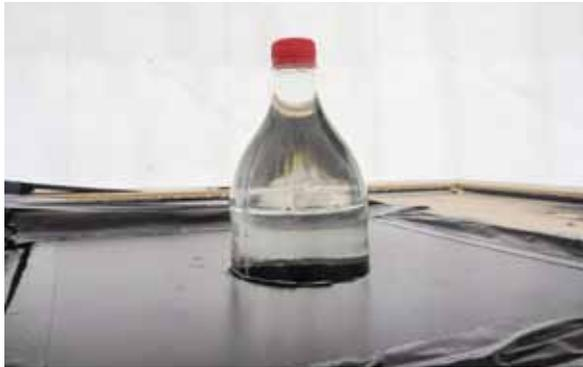
Abb.34 Die Solarbulb ist randvoll mit Wasser gefüllt
